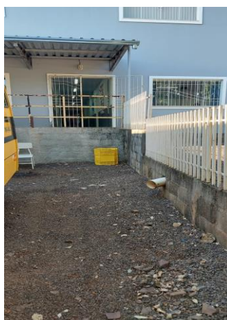
Fotografia 02: Drenagem Pluvial – existente
