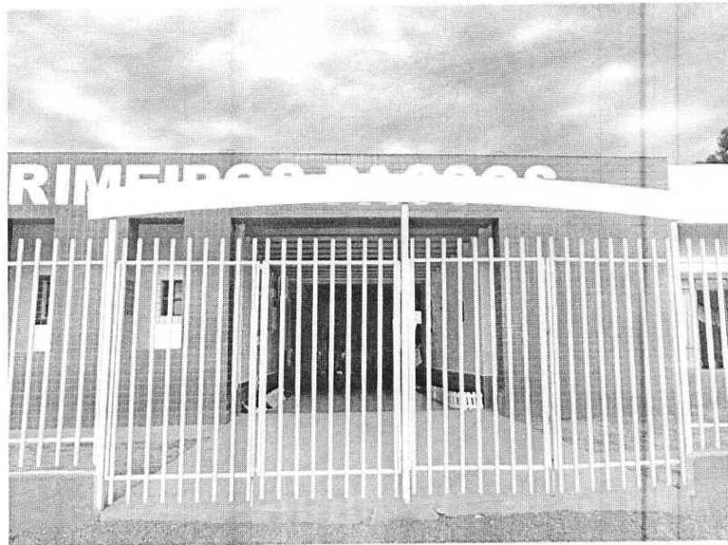
Toldo - Pórticos, tubo redondo, telhas de aluzinc
